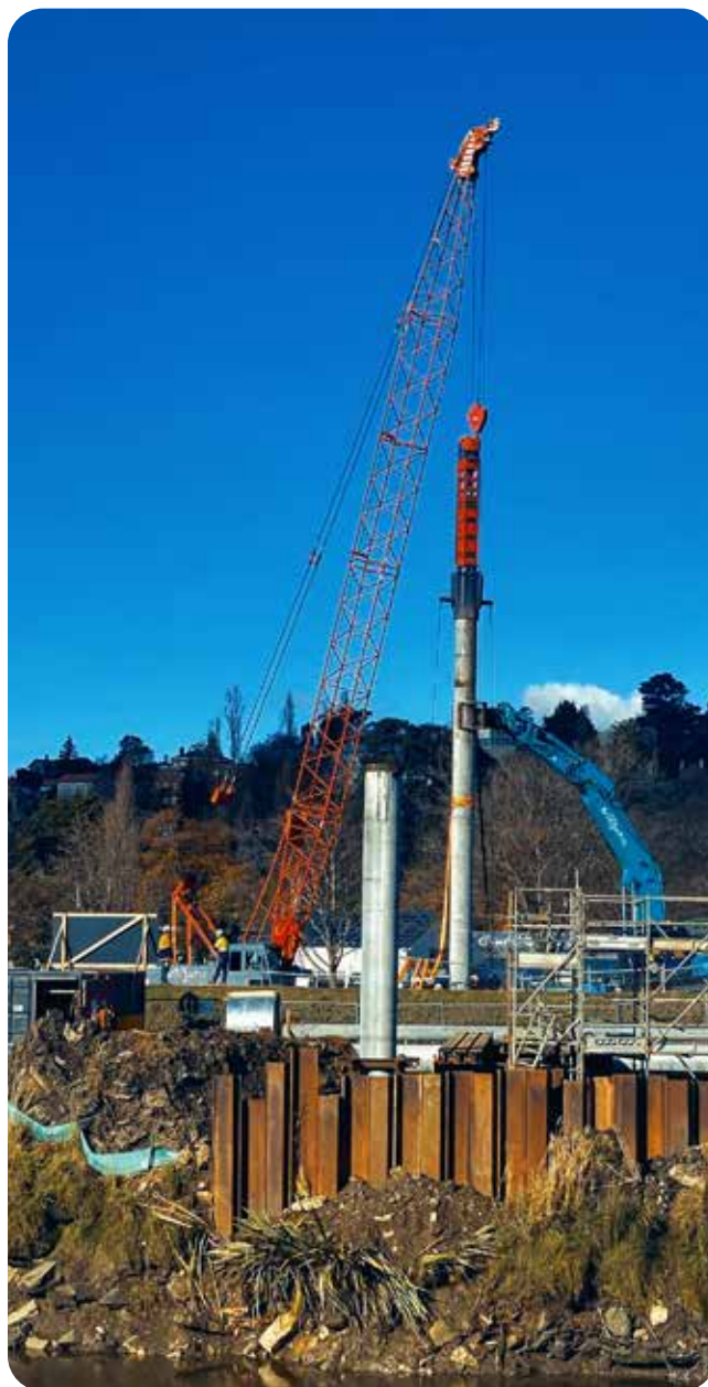
Montado no líder de cravação multi- ferramenta (MPL)
